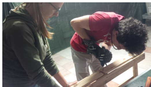
Figura 6: fase lavorazione bancale
